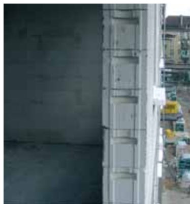
Otwór okienny o powierzchni niegotowej
