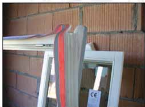
taśmy paroprzepuszczalna i paroszczelna wyklejone na ramie okna
