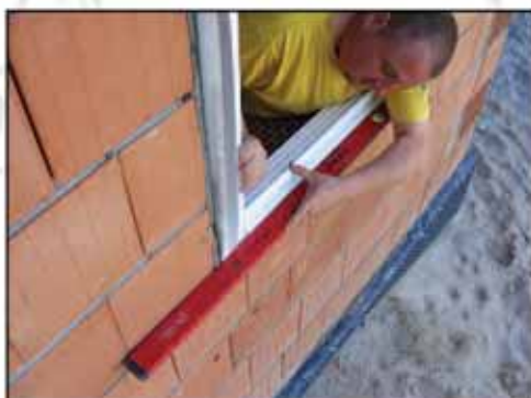
umieszczenie ościeżnicy w otworze okiennym
