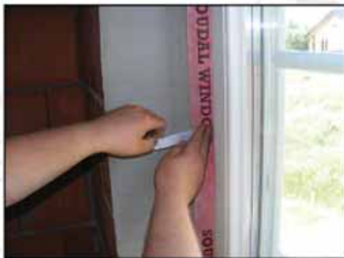
wyklejenie taśmy paroszczelnej wewnątrz budynku
