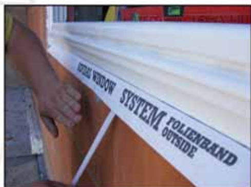
wyklejenie taśmy paroprzepuszczalnej na zewnątrz budynku
