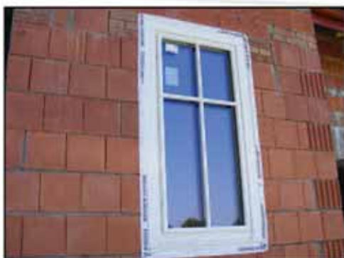
okno po montażu, na zewnątrz
