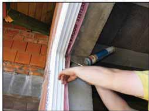
uszczelnienie okna pianką montażową
